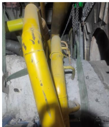
Рисунок 3.8.8 – Итоговая конфигурация газового коллектора с отклонением верхней части в сторону от топki
