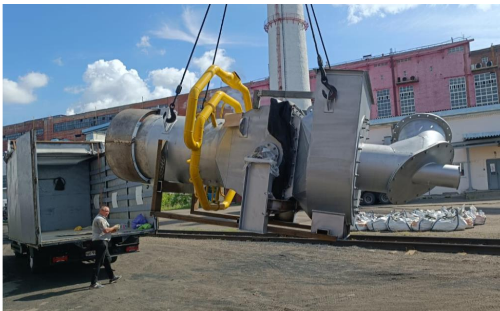
Рисунок П5.1 – Поставка пилотного образца поворотной горелки на Томскую ГРЭС-2
