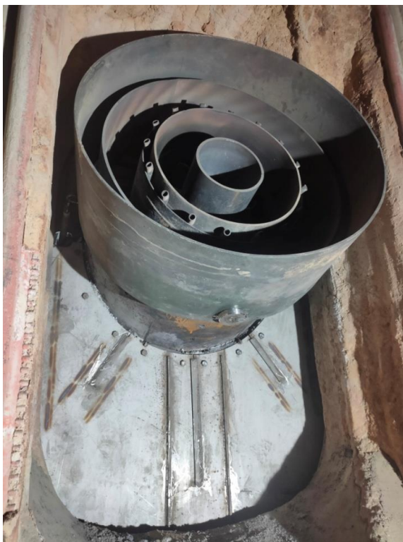
Рисунок 4.2.4 – Поворот горелки на холодном котле, вид изнутри топки (слева поворот на +15^\circ , справа поворот на -15^\circ )
