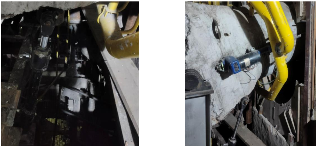
Рисунок 3.8.4 – Гидроцилиндры, смонтированные по новой схеме (слева вид ГЦ при горизонтальном положении горелки, справа – при повороте на +15° при разомкнутом щите)
