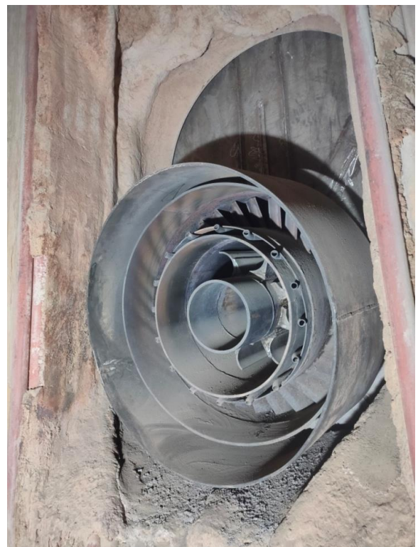
Рисунок 4.2.4 – Поворот горелки на холодном котле, вид изнутри топки (слева поворот на +15^\circ , справа поворот на -15^\circ )
