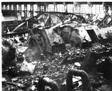
Рис. 4. Общий вид ТА 300 МВт после аварии (2002 г.).
