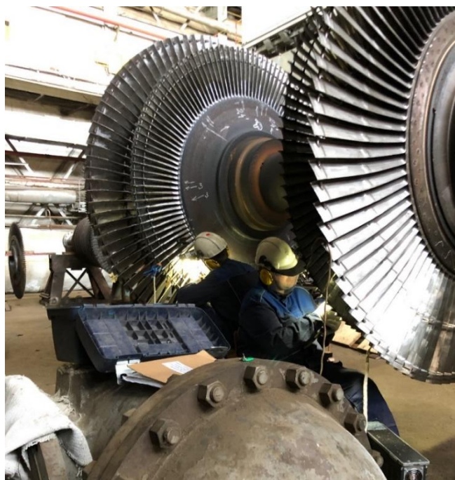
Рисунок 1. Формирование покрытия на входных кромках рабочих лопаток последних ступеней при положении ротора на козлах ремонтной площадке
