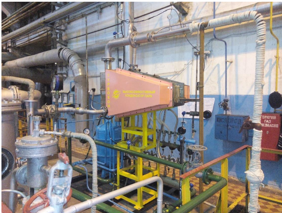
Рисунок 27 – Модуль высокоэффективного конденсатора (ВЭК) на ТЭЦ ПАО «Калужский турбинный завод»
