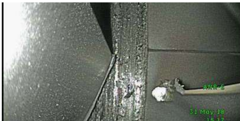
Рис. 4. Следы соударения на статорных и роторных лопатках 10–11-й ступени компрессора
