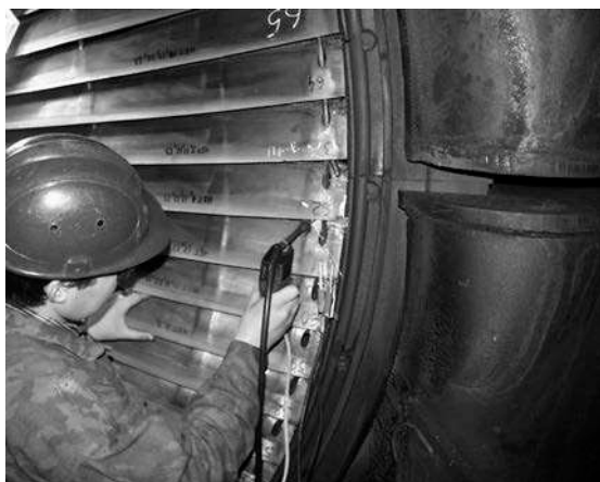
Рис. 2. Нанесение металлатором защитных покрытий на лопатки 29-й ступени через конденсатор при ремонте турбины К-300-240 ЛМЗ ОАО «Рязанская ГРЭС» (ст. № 3)
