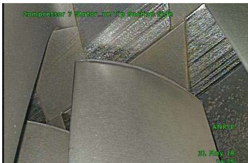
Рис. 2. Следы задевания статорных лопаток 7-ой ступени о ротор компрессора
