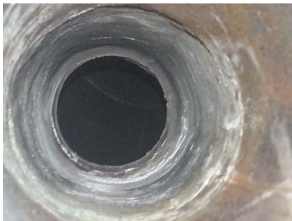
Внутренняя огнеупорная изоляция после серии опытов
