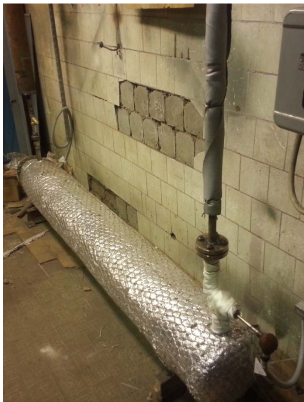
Пароперегреватель ППЭ-10
