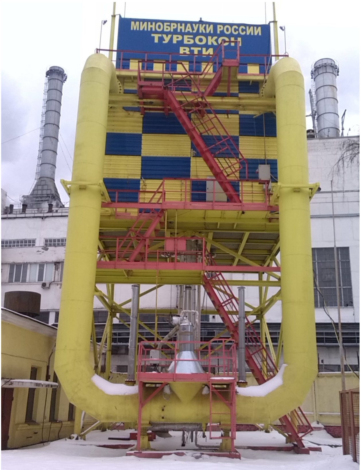
Рисунок 4.1. Фотография ЭСВК на территории ОАО «ВТИ» во время зимнего этапа испытаний при отрицательных температурах наружного воздуха (фото автора)
