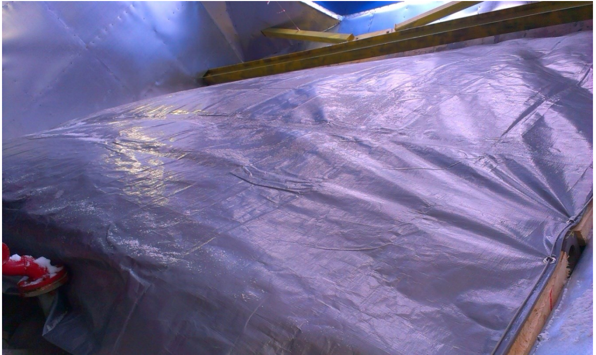
Рисунок 4.7. Вид теплоизолирующей шторы при подаче пара на прогрев (фото автора)
