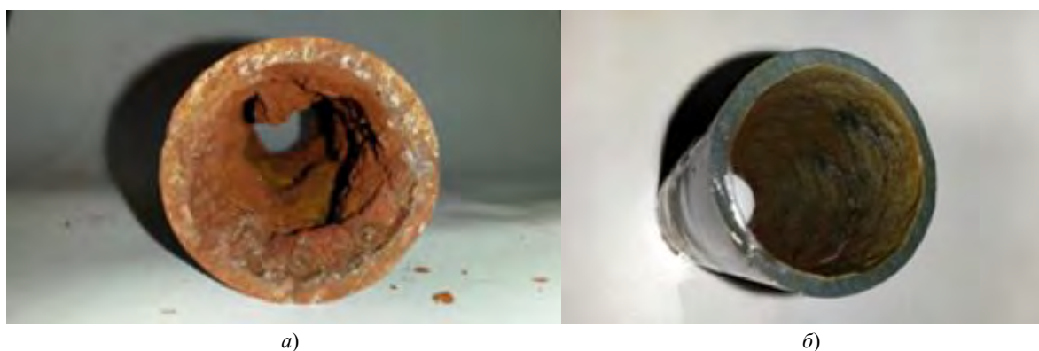
Рис. 3. Результаты очистки системы отопления с помощью БиЗ-1: а – до очистки; б – после очистки
