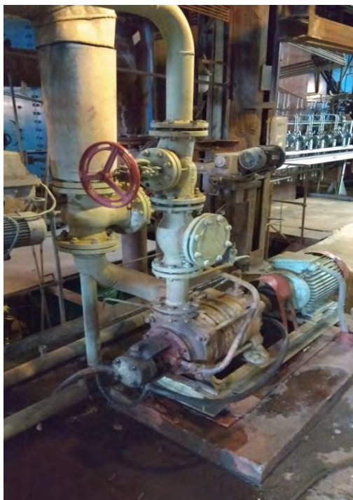
Рис. 4. Дистиллятный насос испарителя модели КС-32-150
