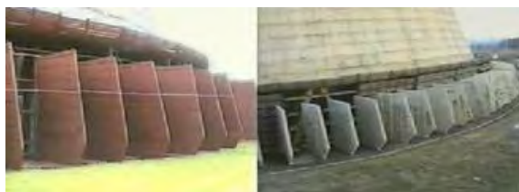
Рис. 6. Аэродинамические завихрители Минской ТЭЦ-4
