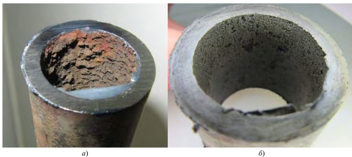
Рис. 1. Результаты очистки труб водогрейного котлоагрегата с помощью БиЗ-1: а – до очистки; б – после очистки
