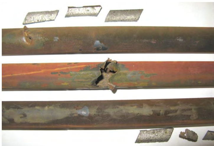
Рис. 5. Фрагменты поврежденных трубок и найденные в конденсаторе стеллитовые пластины (в том числе и застрявшие в трубках) после отрыва от входных кромок рабочих лопаток 30-й ступени турбины ПТ-65/75-130/13 ЛМЗ
